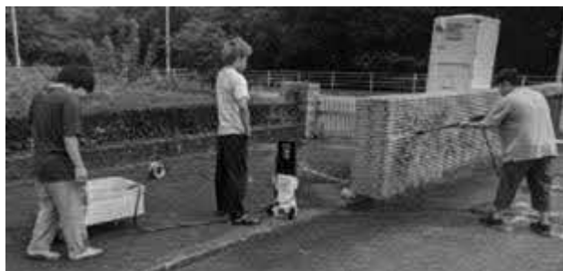
図 4 壁面清掃作業
